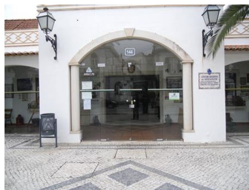
Figura 73 –Edifício Centro Regional de Artesanato
