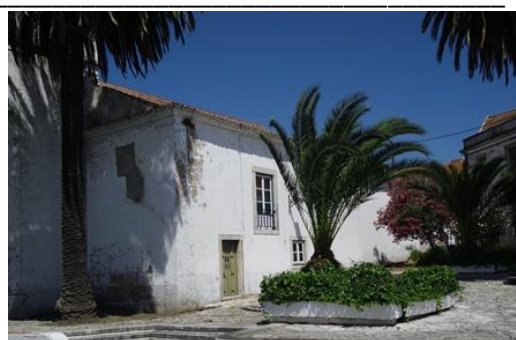
Figura 17 – Vista do Largo da Misericórdia
