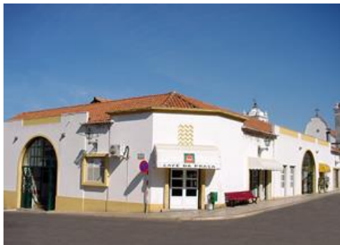
Figura 69 – Vista do Mercado Municipal
