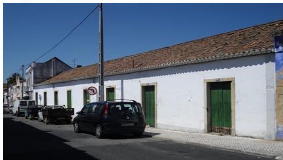
Vista edifício Rua Câmara Pestana
