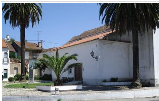
Figura 16 – Vista do Largo da Misericórdia
