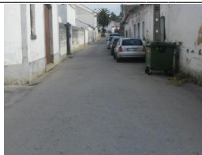
Figura 58 – Vista de arruamento sem passeios
