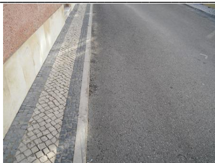
Figura 57 – Vista de passeio com dimensões reduzidas
