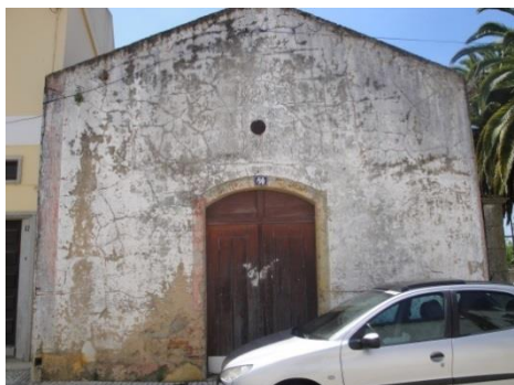
Foto 9 - -Edifício SIG 1407_13_51, sito na Rua Anselmo de Andrade, SN
