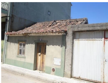
Foto 7 - -Edifício SIG 1407_13_12, sito na Rua Anselmo de Andrade, SN
